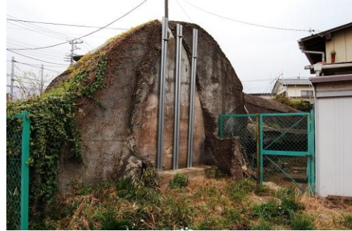
ロケット戦闘機秋水地下燃料庫跡（柏市）
