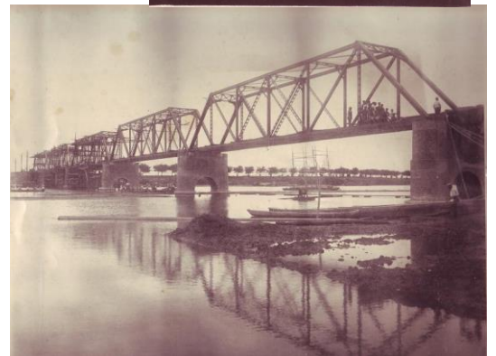
<鉄道連隊による江戸川架橋工事>
