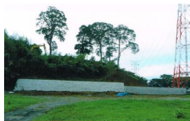
<東南斜面の工事(2013.8)>
